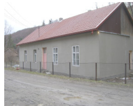
Skolen i Baia Noua under ombygning
