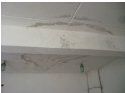
Loftet ser ikke så godt ud, vandet er trængt ned gennem det utætte tag
